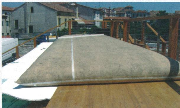
strato per inverdimento pensile estensivo (15 centimetri) costituito da una miscela a frazione minerale a base di tegole di laterizio selezionato, frantumato, vagliato e arrotondato. La superficie verde, così come è stata realizzata, risulta completata dalla rete di irrigazione e dalla rete di illuminazione che alimenta i fari segnapassi posti in corrispondenza degli inserti in pietra bianca che costituiscono i camminamenti principali.
